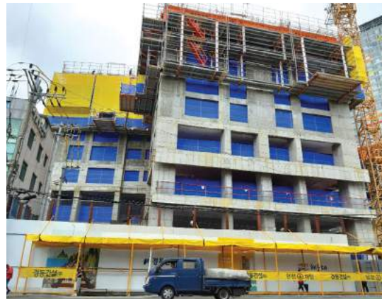
경동건설 _ 부산 해운대 리인뷰 현장
