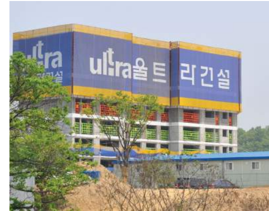
울트라건설 _ 서초 현장
