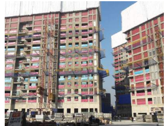
롯데건설 _ 수색 현장
