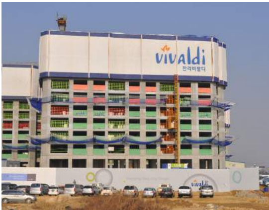
GS건설 _ 인천청라 현장
