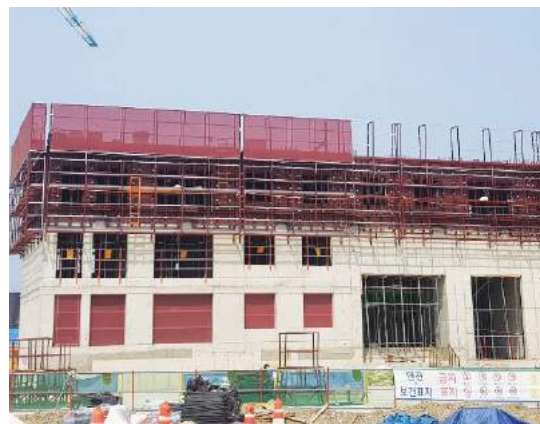
현대건설 _ 학익동 현장
