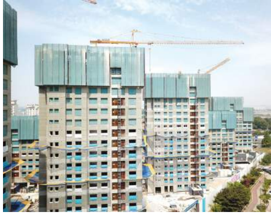
삼정건설 _ 그린코아 현장
