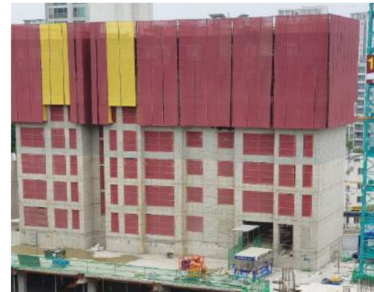
롯데건설 _ 상도 현장
