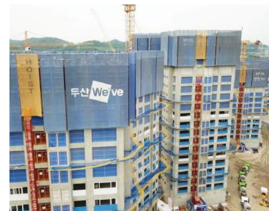
두산건설 _ 시흥대야 현장
