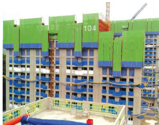
양우건설 _ 의왕고천 현장
