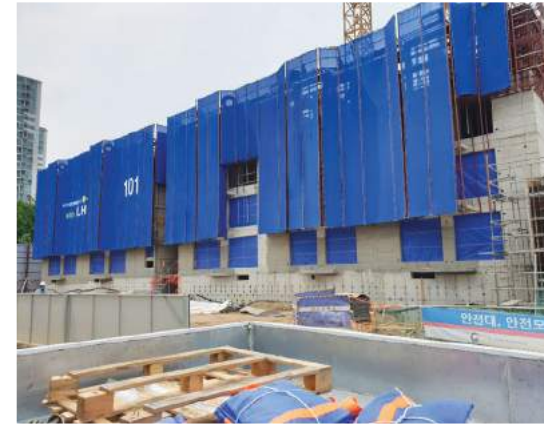
대창기업 _ 양주덕정 현장
